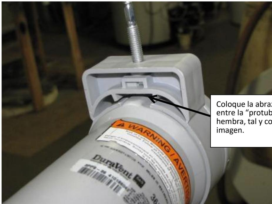
Coloque la abrazadera de modo que encaje entre la "protuberancia" de la brida hembra, tal y como se muestra en la imagen.
