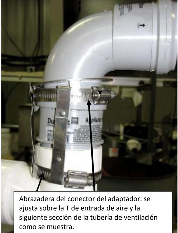
Para la salida de ventilación de todos los modelos de ventilación eléctrica y ventilación directa eléctrica, inserte el adaptador de PVC en el adaptador de la salida de escape. En los modelos residenciales, apriete la abrazadera para asegurar el adaptador de PVC.
