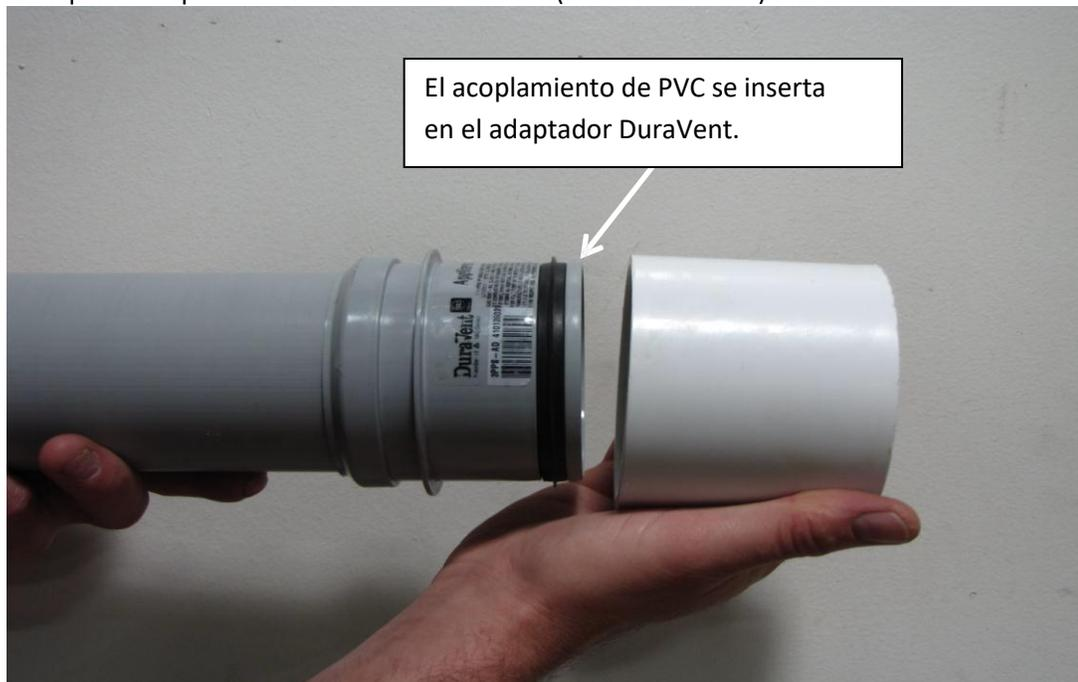
Fije el acoplamiento de PVC al adaptador del terminal de PVC con la abrazadera para la tubería de combustión DuraVent. Pegue una sección corta de la tubería de PVC en el acoplamiento de la tubería de PVC. Pegue el acoplamiento del terminal de salida de PVC suministrado a la tubería de PVC.
