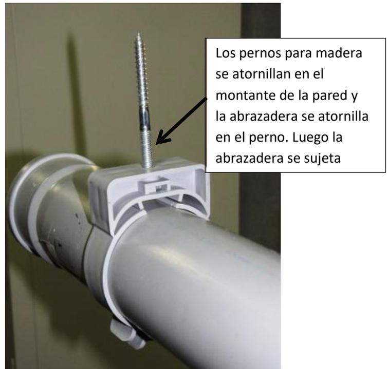
La abrazadera de plástico también se coloca sobre la brida hembra de las secciones de la tubería de ventilación DuraVent.
