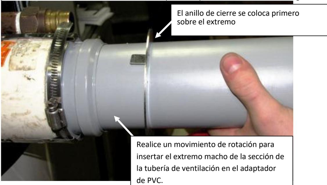
Fije el anillo de cierre a la unión deslizando el gancho sobre el reborde de la junta como se muestra a continuación.
