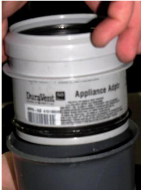
Coloque la abrazadera del conector del adaptador sobre el adaptador de PVC e inserte el codo o la siguiente sección de tubería recta en el adaptador de PVC. Luego apriete los anillos de la abrazadera del conector del adaptador alrededor del adaptador de la salida de escape y el codo para fijar el sistema de ventilación.
