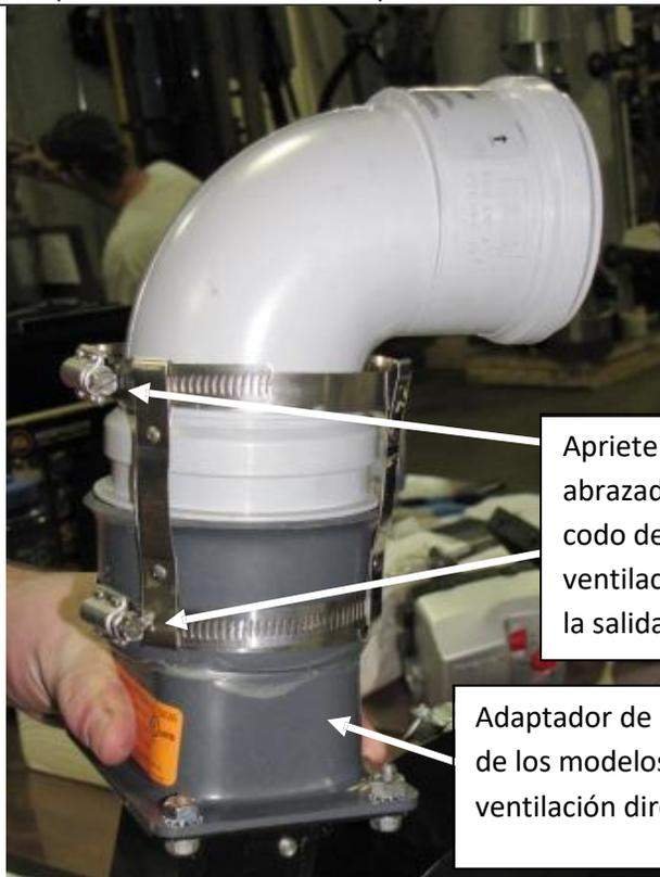
Apriete los tornillos de la abrazadera para fijar el codo de la tubería de ventilación al adaptador de la salida de escape.
