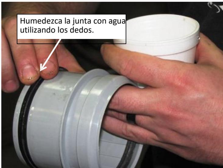
Humedezca la junta con agua utilizando los dedos.
