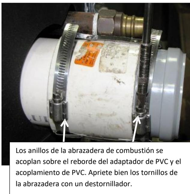
Los anillos de la abrazadera de combustión se acoplan sobre el reborde del adaptador de PVC y el acoplamiento de PVC. Apriete bien los tornillos de la abrazadera con un destornillador.
