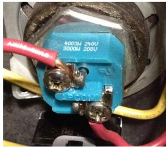
**Figure 13.** Exemple de marquage du wattage/tension sur l'élément
