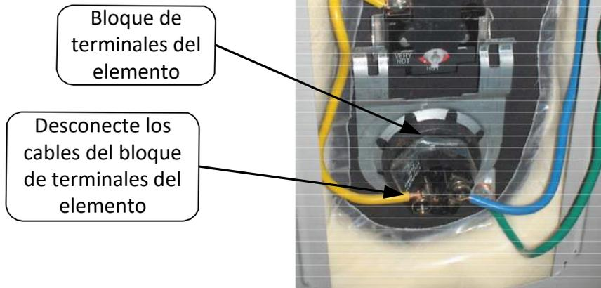
7. Retire los elementos del tanque con una llave de cubo larga de 1 ½" o la llave correspondiente. Desenrosque los elementos hacia la izquierda para retirarlos del tanque.
