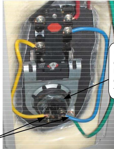
Enrosque los elementos hacia la derecha en el tanque
