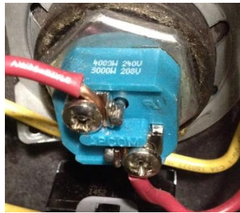
Figure 13. Exemple de marquage du wattage/tension sur l'élément
